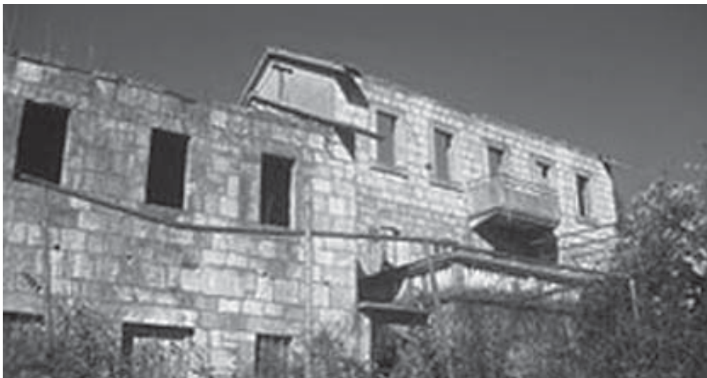
Slika 2.: Spaljene i uništene kuće u selu Ravno u listopadu 1991.
